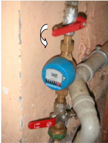
L'arrivée d'eau est ouverte lorsque les deux vannes rouges sont parallèles au tuyau.
